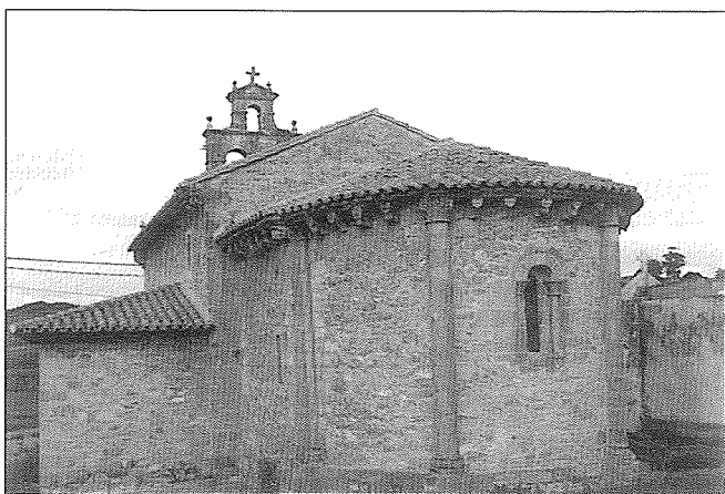
Fig. 1.—Abside de la iglesia de San Jorge de Manzaneda.
