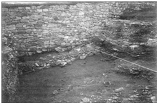
Fig. 7.—Sector XII en el que se aprecia como la zapata fundacional de la muralla pasa por debajo de las piedras del muro que ciñen el paso de ronda (a la derecha de la foto).
