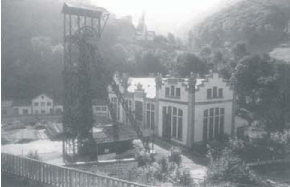
FIGURA 49. Vista panorámica del castillete y sala de máquinas del pozo San Luis, junto con la edificación adyacente en La Nueva-Ciaño (Langreo)
