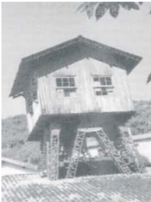
FIGURA 48. Vista superior del castillete del pozo Espinos en Turón (Mieres)
