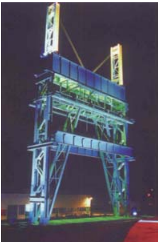
FIGURA 121. Fragmento de apoyo conservado de la antigua sala de máquinas M1
