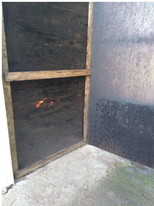
Figura 2. Salida de aire habilitada en la parte baja del ahumadero para facilitar la ventilación
