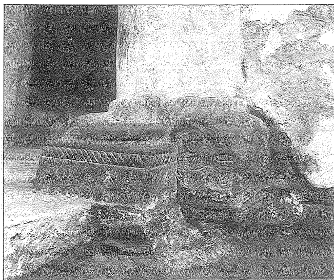
Fig. 4.—Oviedo, San Miguel de Liño, vista del corte n.º 18 en el interior de la iglesia
