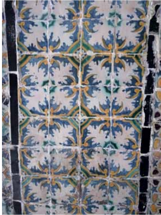
LÁMINA VI: Dār Romḍān Bey, detalles de la azulejería de la sqifa .
