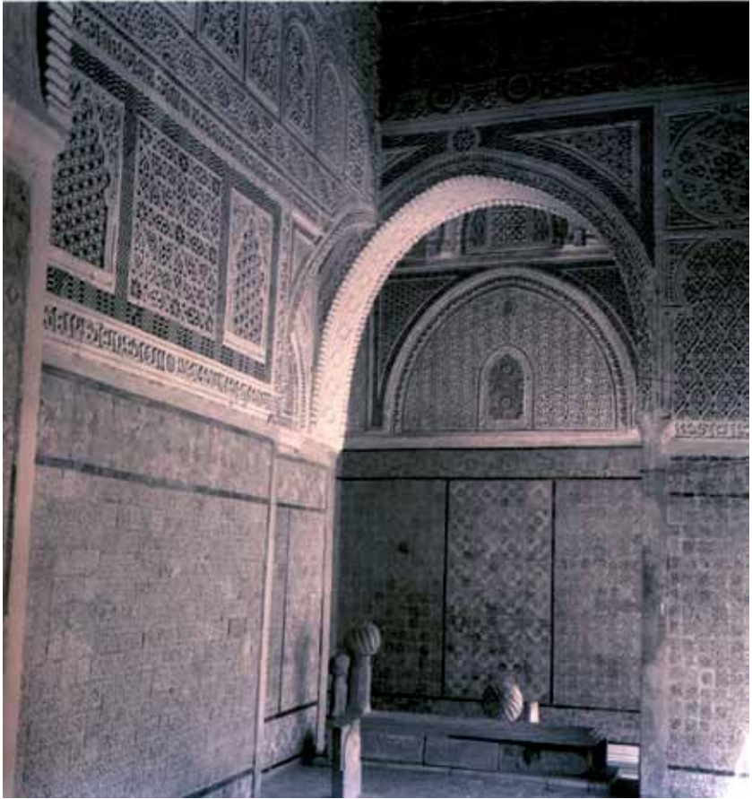
LÁMINA X: Turba 'Azīza 'Oṭmāna, azulejería de época muradí donde se observan los listones negros que dividen la superficie.
