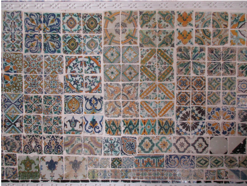
Figure 1 : Palais du Bardo, Alger. Carreaux tunisois de Qallaline, matériaux de rempli.
