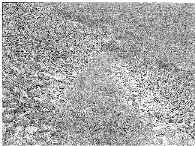
Fot. 3.—La línea de vegetación que atraviesa el argayo indica el paso de uno de los múltiples canales de las explotaciones mineras de la Sierra del Palo
