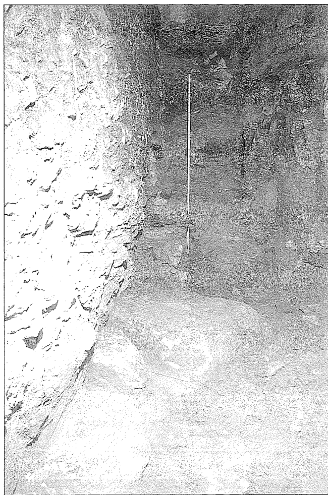
Fig. 2.—Casa Campomanes. Cimentación del lienzo E. Vista S.S.E.
