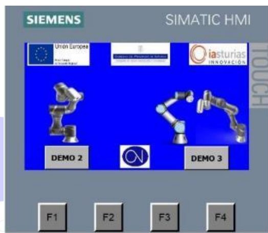
Figura 149. Pantalla inicial de la interfaz diseñada para el panel táctil HMI Siemens KTP400
