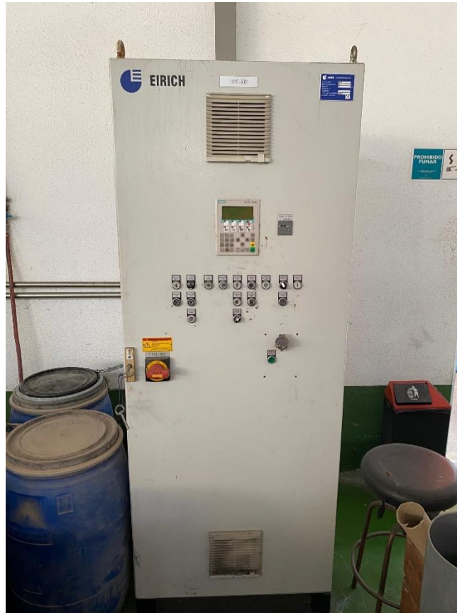
Figura 108. Detalle del cuadro de mandos de la mezcladora para el colado.
