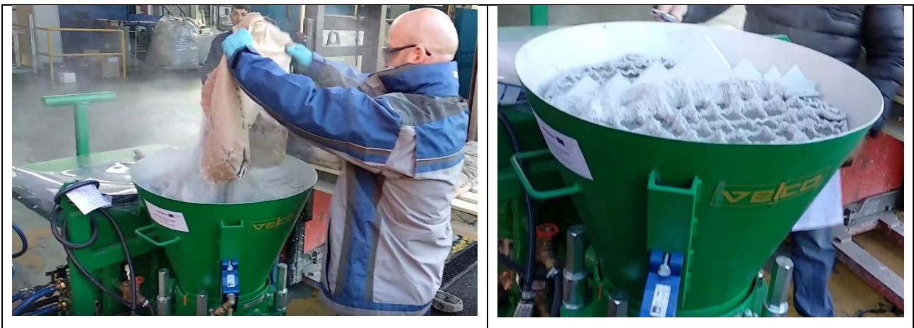
Figura 102. Operación de carga de la tolva de alimentación del hormigón seco a la gunitadora.
