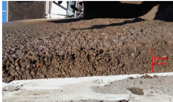
Figura 104. Detalle del espesor de la capa gunitada de hormigón Baux.
