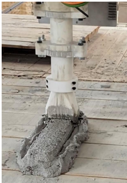
Figura 96. Detalle de la impresión del hormigón refractario BAUX.
