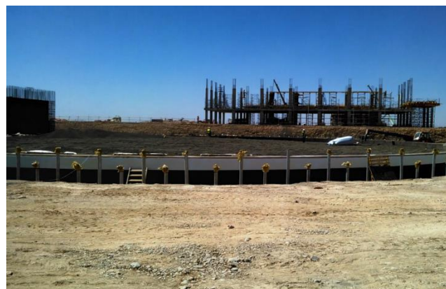
Figura 2. Cimentación de material refractario aislante de un tanque de almacenamiento de sales fundidas
