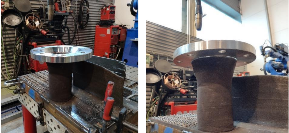
Figura 36. Proceso de fabricación de la tubuladura
