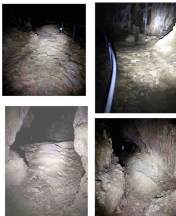
Figura 5: Tito Bustillo. Vista de las afecciones en el tramo de camino comprendido entre la Galería de los Caballos y el Conjunto de la Ballena (inundación del 6 de febrero de 2021). [Consejería de Cultura. Fotografías de los autores].
