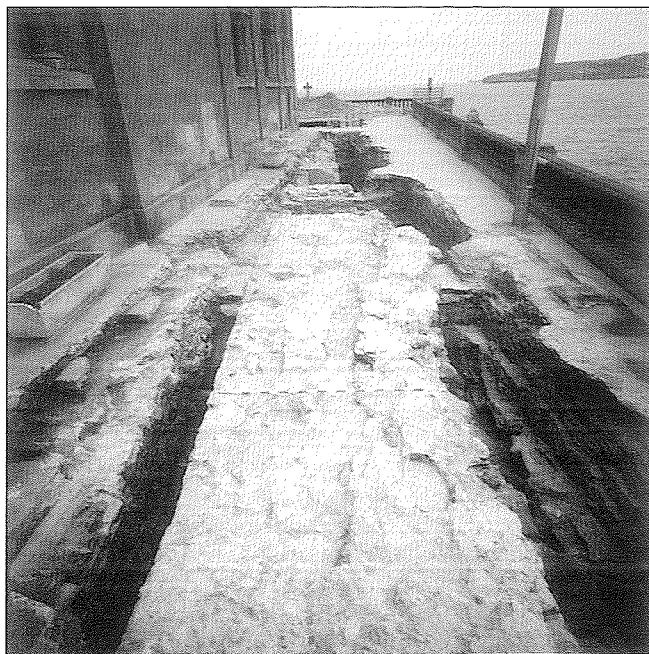
Fig. 1.—Trazado de la muralla tardorromana detrás de la Iglesia de San Pedro (Gijón)
