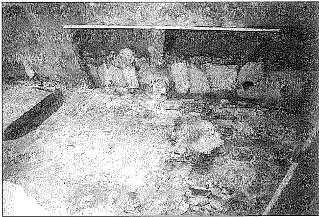
Fig. 3.—Vista general de la canaleta y de la puerta de acceso a la torre bajomedieval descubierta al eliminar la carga de la pared.
