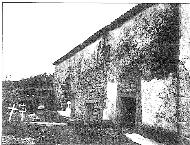
Foto 2.—San Pedro de Nora en 1935. Aspecto del lado norte.
