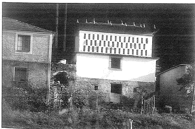
Fig. 8.—Cabazo con anforetas decorativas en el tejado. Castropol.
