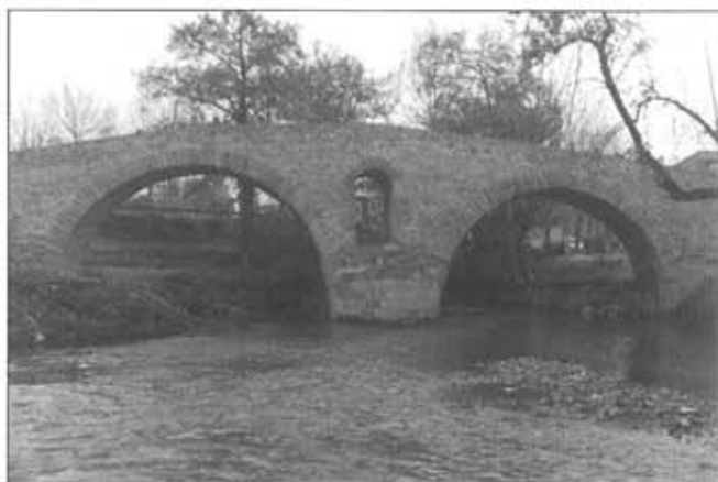
Fig. 4.—El puente de Colloto una vez finalizados los trabajos de restauración, ya sin andamiajes y antes de la eliminación de los limos fluviales que ocultaban la parte de la estructura resdescubierta en la actualidad.
