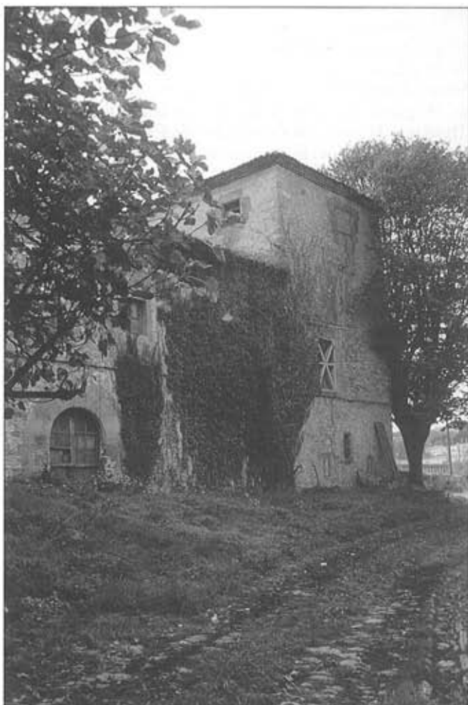
Palacio de Trasona; vista desde el lado este de la torre bajomedieval del edificio.
