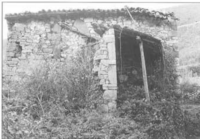
Foto 1.-Fachada oriental de la Torre del Palacio. En primer término las ruinas de la vivienda que se encontraba adosada a la antigua edificación; detrás, la primitiva puerta de acceso, tapiada, y a su izquierda, a la misma altura, una de las saeteras, parcialmente arruinada.
