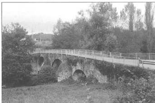
Foto 2.—Aspecto actual del Puente de Gallegos.
