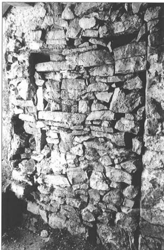
Lám. 2. Vano descubierto en la pared norte de la nave de la capilla primitiva.
