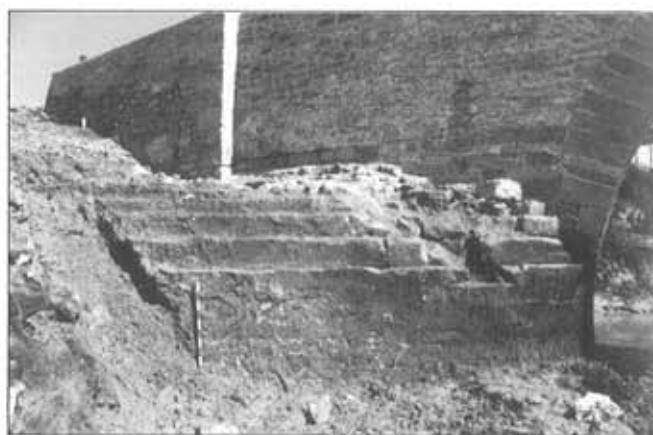
Fig. 3.—Contrafuerte localizado durante el seguimiento arqueológico. Todo parece indicar que pertenece a la obra primitiva del puente.
