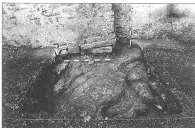
Lám. 1. Detalle de la cimentación sobre la roca, a la altura de la conexión sur ábside-nave.
