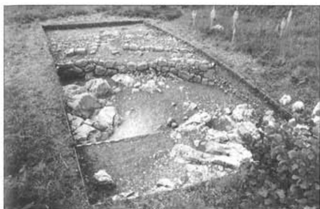
FOTO 4.—Detalle del estado de conservación de la muralla en el Sector Occidental, visto desde el interior del recinto. Se puede apreciar la construcción de la muralla a base de módulos.
