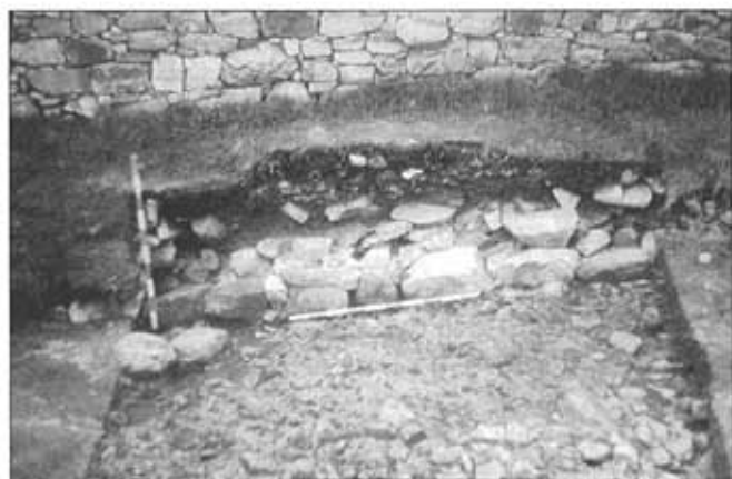
Lámina III.-Sector XV. Zapata fundacional de la muralla y estrato VII sobrepuesto.
