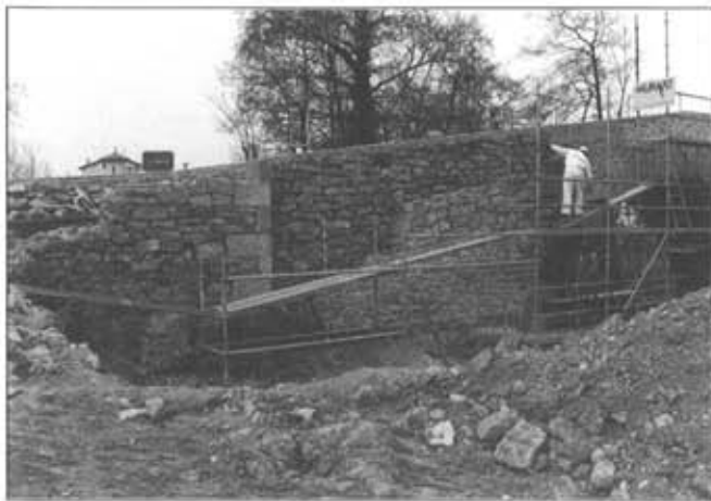
Fig. 1.-Aspecto del puente durante las obras de restauración. Pueden observarse diferentes unidades estratigráficas murarias correspondientes al arco izquierdo aguas arriba.
