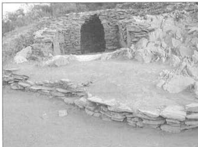
Lámina 4.—Pendia 1. Los trabajos de consolidación, con dirección de Carlos Álvaro Cirveches, consistieron en el refuerzo de los muros de cabecera, reintegración del revestimiento perdido en la caldera y la limpieza superficial de muros mediante cepillado seco y con agua.
