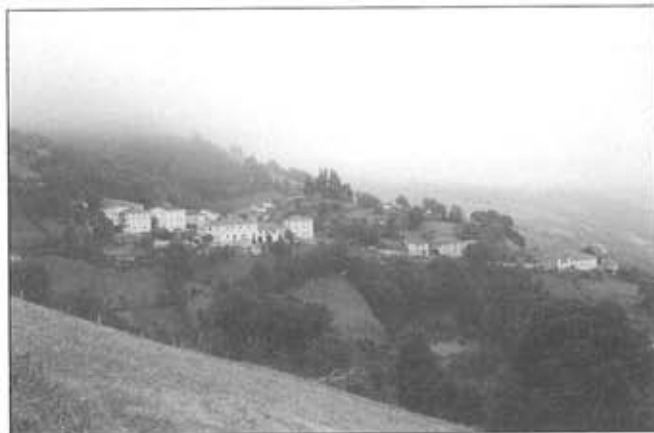
Lámina 3.—Vista general del "Castiechu" de Pexán, integrado ya en el caserío de dicha localidad canguesa.
