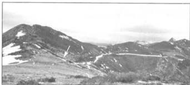
Lámina 5.—Camín Real de La Mesa. Panorámica del sector de la vía situado entre el collado del Muro y el Alto La Madalena —al fondo—, con el gran foso del Muro, en primer término señalado con la flecha.
