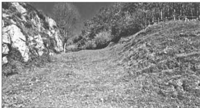
Lámina 3.—Asentamiento fortificado del Castiecho. Detalle del tramo de foso que bordea el flanco nororiental del recinto.
