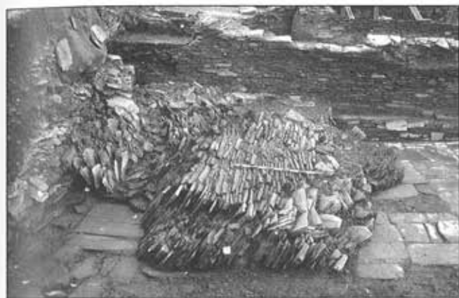
Lámina 9.—Durante la segunda mitad del siglo II d.C. el poblado fue destruido como consecuencia un terremoto. Los graves daños, producidos en un momento en el que ya se anunciaba el ocaso de los poblados castreño-romanos, no fueron jamás reparados y el Chao Samartín resultó definitivamente abandonado (Foto: A. Menéndez).
