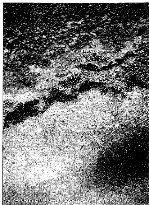
Foto 5.—ARENAZA: Grieta de la pared rellena de cristales de calcita y yeso.
