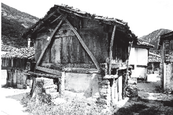
El tejado a dos aguas presentaba mayores dificultades, ya que el reparto de fuerzas sobre la estructura provocaba deformaciones que hacían aconsejable un mayor número de apoyos. En el ejemplar de la fotografía, en Bezares, podemos observar como la parte baja del mismo se ha cerrado desalojando al carro del país y a los aperos de labranza.
