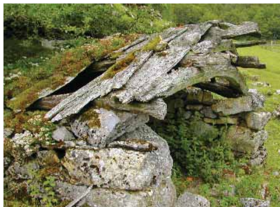
En la fotografía tomada en las inmediaciones del puerto de Tarna se pueden apreciar cabañas, normalmente agrupadas en corros y al abrigo de alguna pendiente o superficie arbolada en su parte posterior, con la peculiaridad de un techo de láminas de madera y no de piedra como en Brañagallones. B. L.
