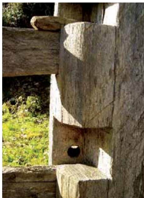
Cierre de finca con tarucos que impiden que los animales puedan levantar los tabloncillos o reyones y acceder a la misma. Isorno. A. L.
