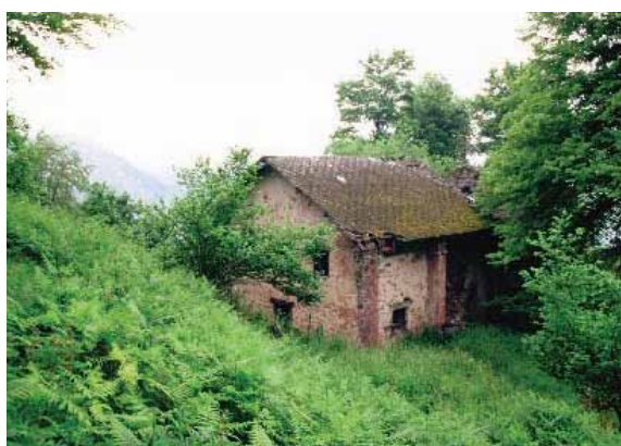
Podemos ver el estado actual del edificio construido para la explotación, solamente visible al acceder por el antiguo camino de la mina.
