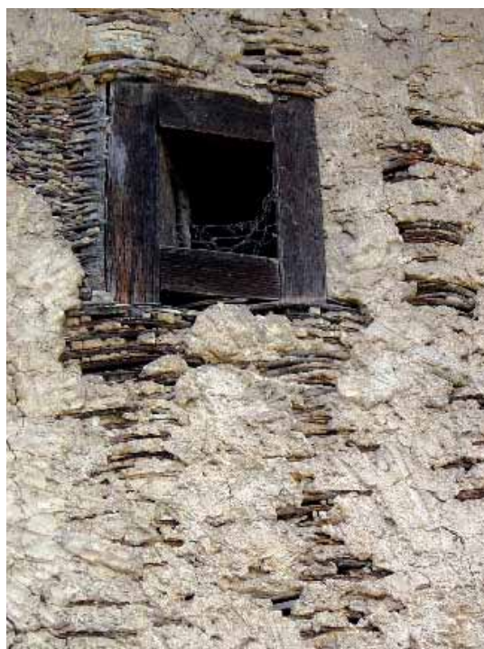
Pared de cebatu, utilizado para cerrar dependencias de la propia casería. En este caso se utiliza un mortero con cal, arena y piedra, para dar más consistencia y aislamiento. Rioseco. B. L.
