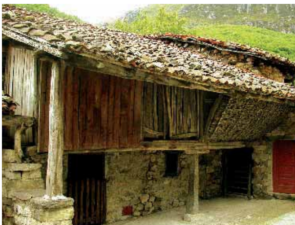
Casa y cuadra normalmente en la planta baja, realizada en mampostería de piedra, y tenada en la parte superior, cerrada con 'cebatu'. Belerda. B. L.
