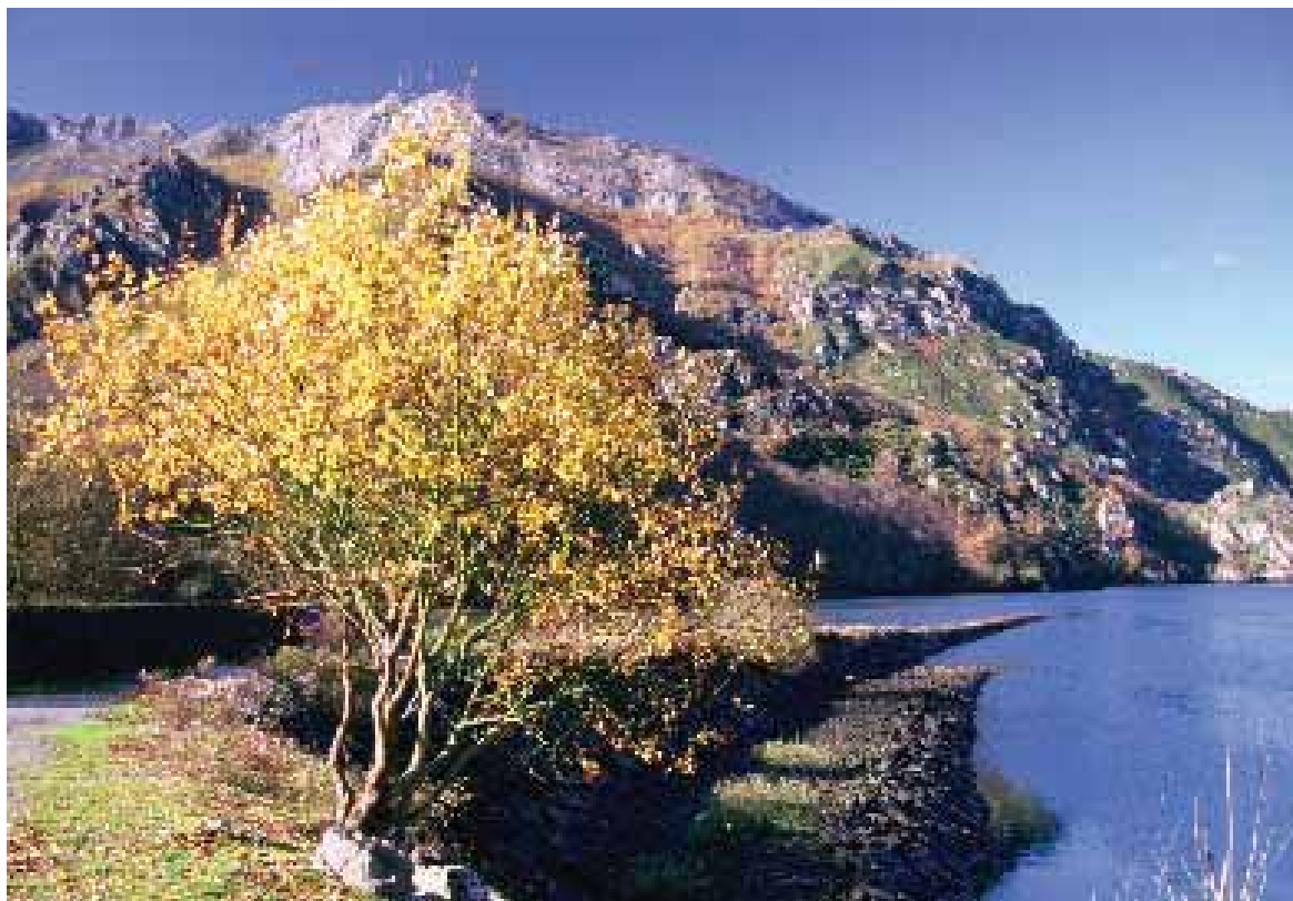
Embalse de Rioseco. Un lugar excelente para la observación de aves, combinado con el aprovechamiento hidroeléctrico y de agua para consumo humano. Rioseco. Sobrescobio. A. L.
