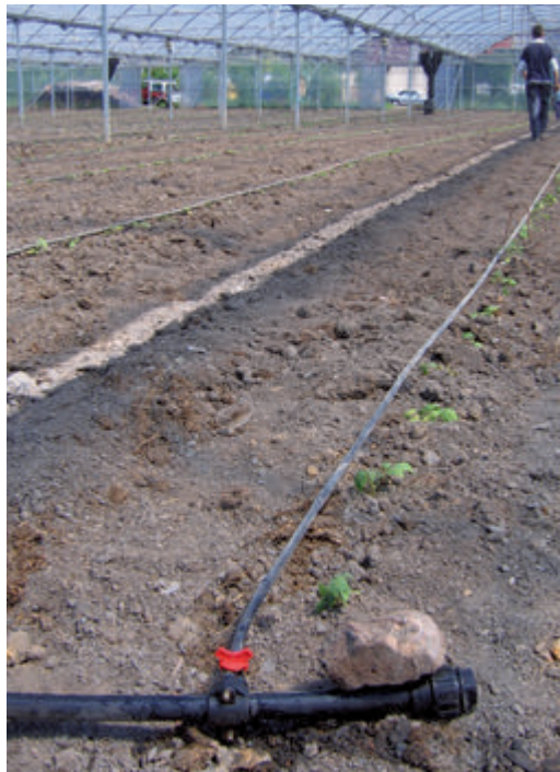
27. Plantación de primavera, con el sistema de riego ya instalado.
