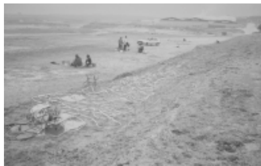
Foto 1. Vista del montaje del dispositivo al completo.
