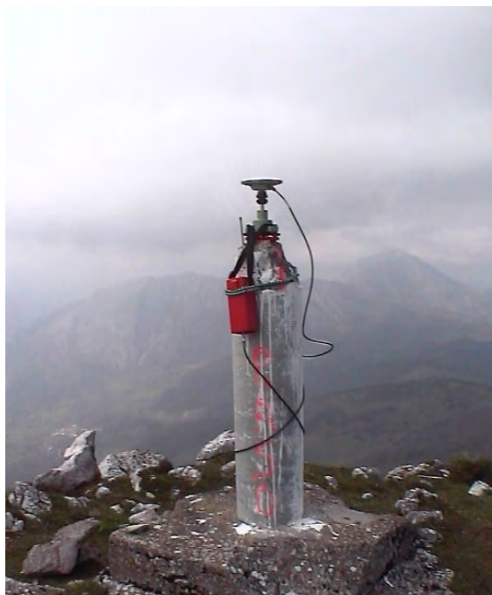
Fig. 67. Vértice REGENTE o de primer orden autonómico. Es necesario informar de su mal estado
