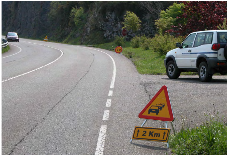
Fig. 66 Ejemplo de señalización para la seguridad en nivelación de precisión por carreteras.
