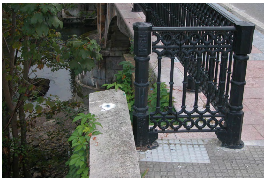
Fig. 39 Señalización de la nueva REDNAP.
