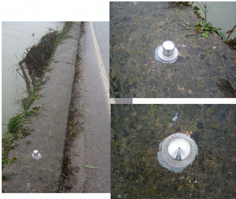
Fig. 144. Clavo de acero inoxidable empleado como señal principal en una línea de nivelación RNPA.
