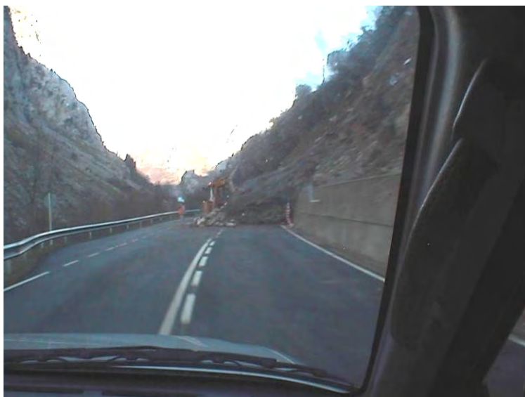
Fig. 121. Estudio particular de los itinerarios. Derrumbamiento provocado por las lluvias.
