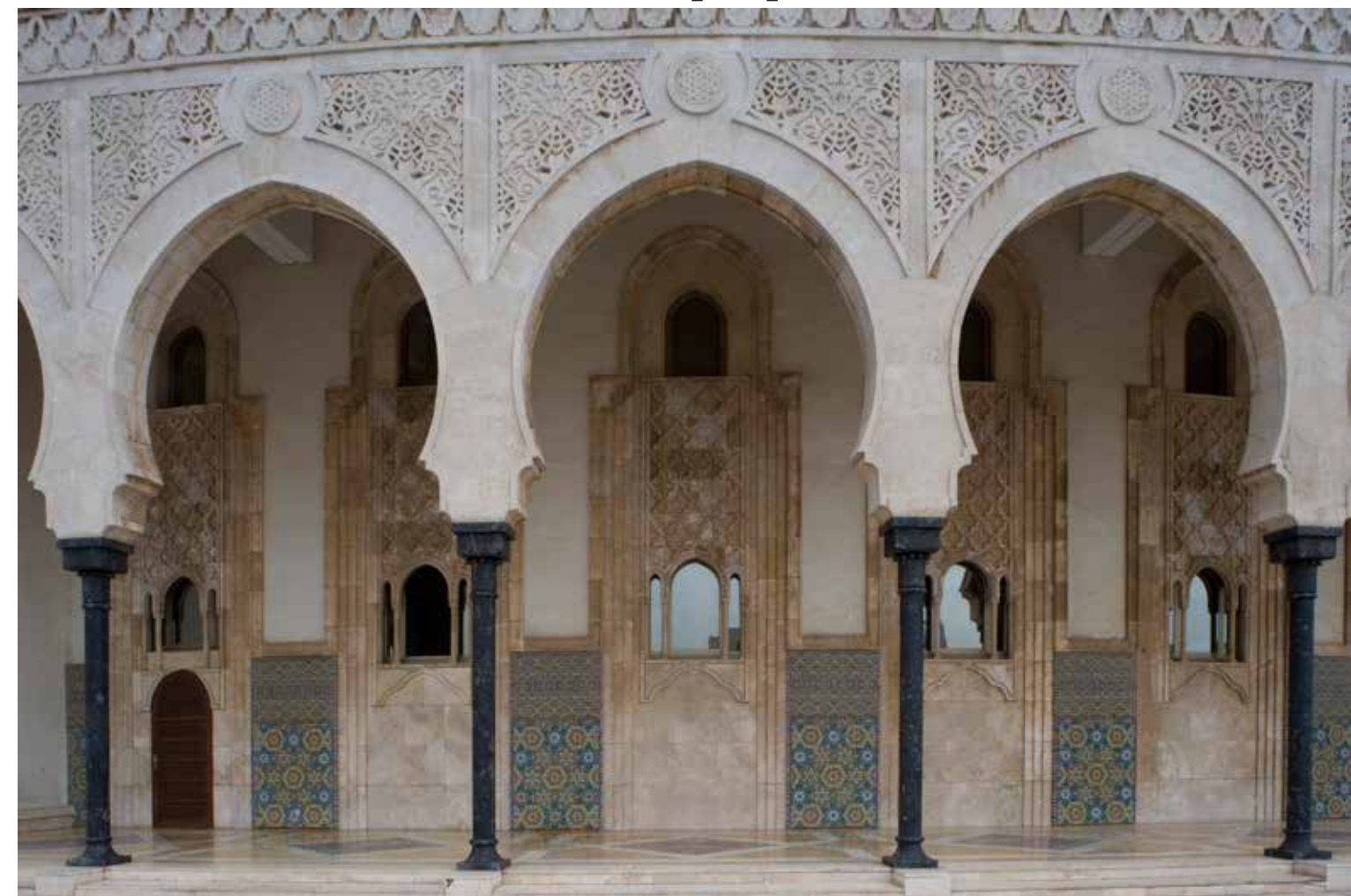
Fig.16. Panneaux de zallidjs des murs du déambulatoire extérieur de la madrasa
